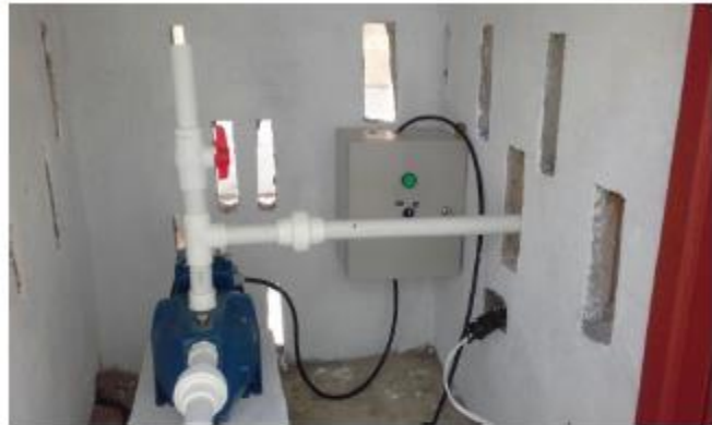
Ilustración 46. Instalación de elctrobomba y caja eléctrica.
