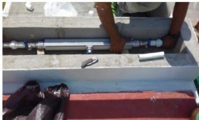
Ilustración 47. Instalación de filtro.
